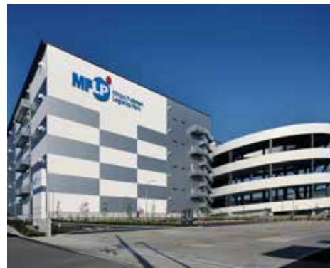
三井不動産ロジスティクスパーク堺 大阪府堺市堺区
