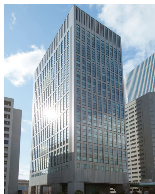
中之島セントラルタワー 大阪府大阪市北区
