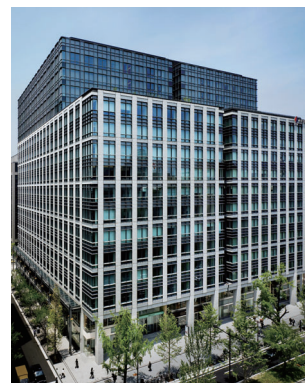
淀屋橋三井ビルディング 大阪府大阪市中央区
