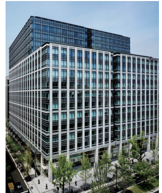
淀屋橋三井ビルディング 大阪府大阪市中央区
